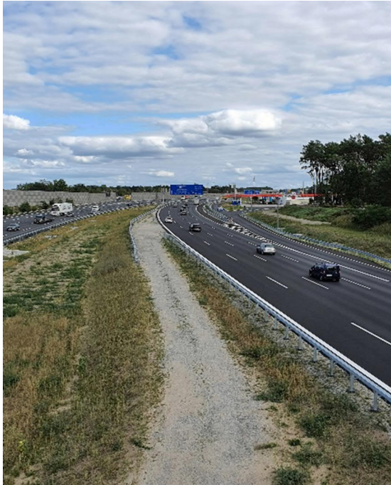
Strecke während der Bauzeit
