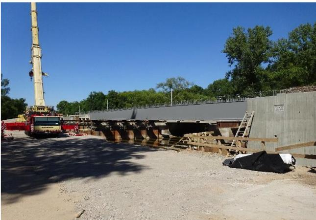
Trägermontage zwischen Pfeiler Achse 30 und Widerlager Achse 40
