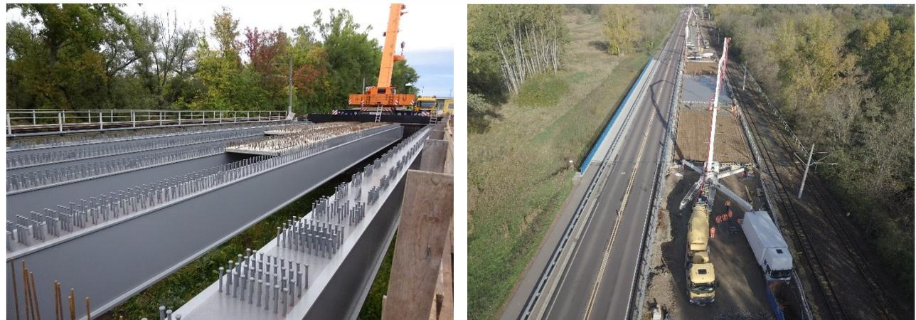
Fertigteilmontage zwischen Pfeiler Achse 30 und Widerlager Achse 40
