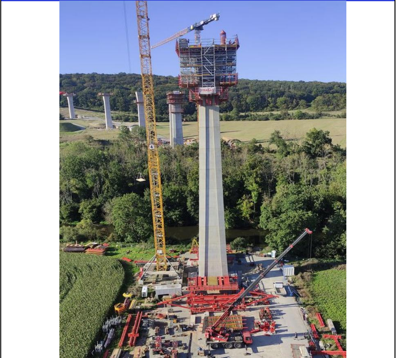
Höchster Talpfeiler - Freivorbau
