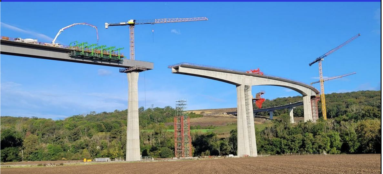
Stahlhohlkasten - Freivorbau
